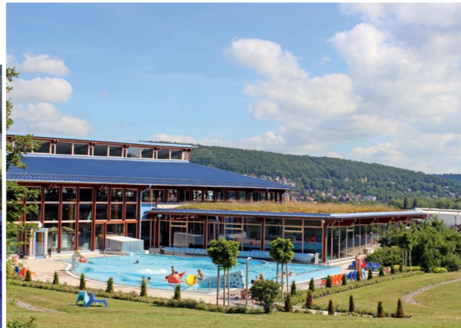
Die Kooperation der beiden Freizeitbäder bringt bereits erste wirtschaftliche Erfolge mit sich.
