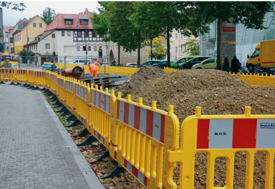
Zwischen Engelplatz und Johannisplatz werden neue Trink- und Abwasserleitungen verlegt.
