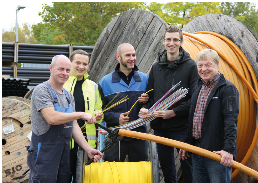
Das Team Informationsnetze der Stadtwerke Jena Netze treibt den Ausbau der Glasfaserversorgung voran.
