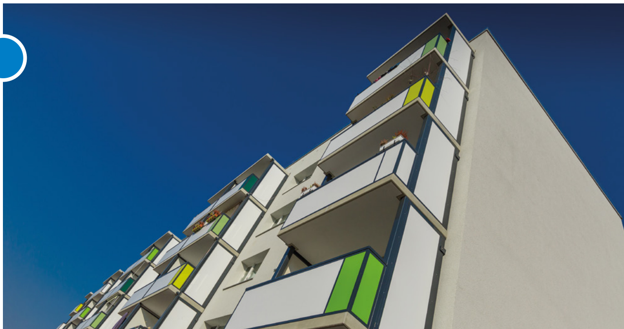
Neben den Neubauvorhaben in Lobeda werden auch immer wieder bereits bestehende Häuser saniert und in einen aktuellen technischen Stand versetzt – wie hier im Binswanger Karree in Lobeda-West.
